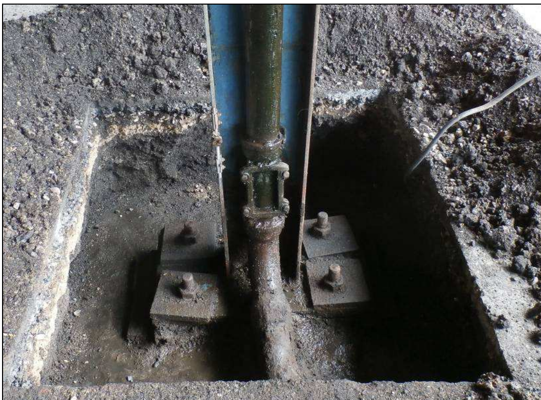
Obr. č. 3 - detail napojení sloupu na patku, ukončení je pod vrstvou asfaltu pouze zasypané pískem a škvárou, toto prostředí je silně provlhčené od netěsnícího svodu a podporuje korozi ocelových prvků
