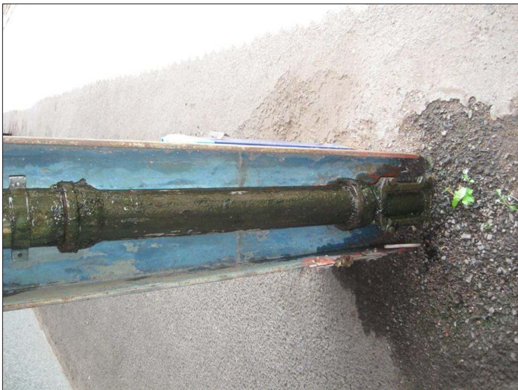
Obr. č. 2 - detail patky sloupu se svodem srážkové vody do dešťové kanalizace. Svod netěsní a trvale zamokřuje patku sloupu a jeho okolí.
