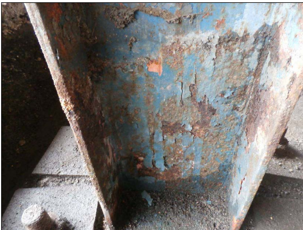
Obr. č. 4 - detail sloupu a degradovaných nátěrů
